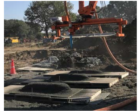
写真-9 供試体作製状況
