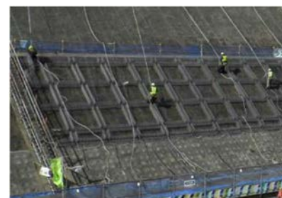
写真-2 鉄筋・型枠組立作業
