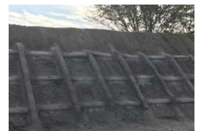
写真-8 格子枠吹付け完了
