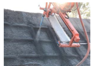
写真-7 縦枠吹付け状況
