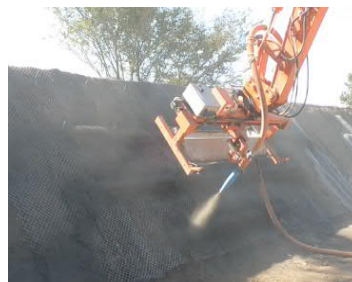
写真-6 横枠吹付け状況
