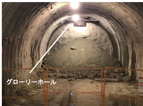
図-15 ずり投下中のトンネル坑内
