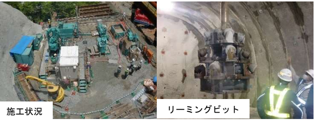
図-12 グローリーホール施工状況
