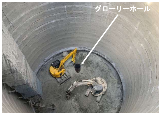
図-14 P3橋脚大口径深礎工施工状況
