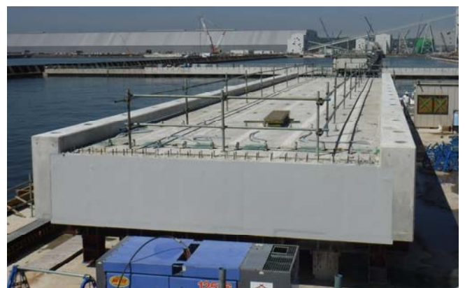
写真-14 揚炭棧橋上で一体化された PC
