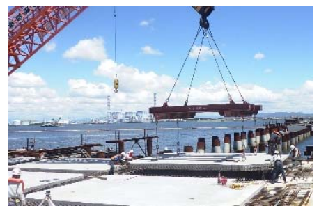
写真-3 Pca スラブの架設
