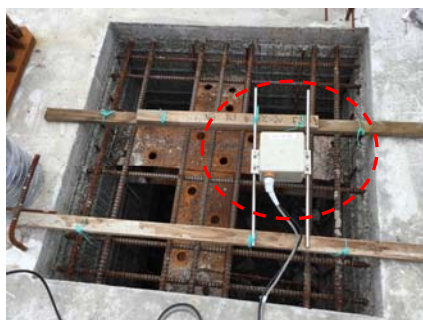
写真-10 架設用カメラ配置（左：全体，右：拡大）
