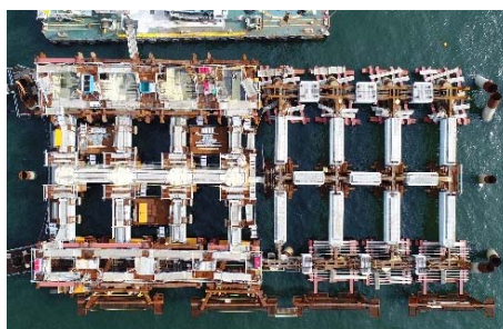
写真-2 施工状況（左：杭頭部，右：梁）
