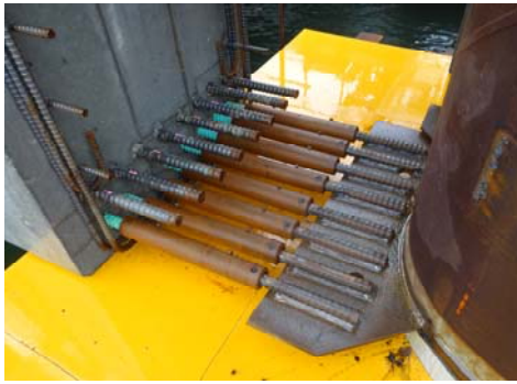
写真-4 機械式継手（モルタル充填式）
