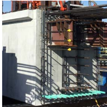
写真-5 梁断面の鉄筋
