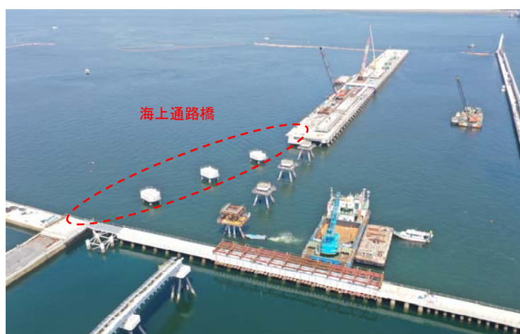
写真-12 海上通路橋架設位置（揚炭棧橋部）
