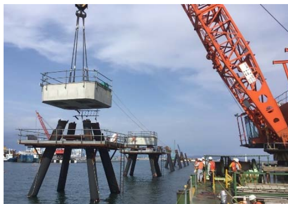
写真-9 Pca ブロック架設状況
