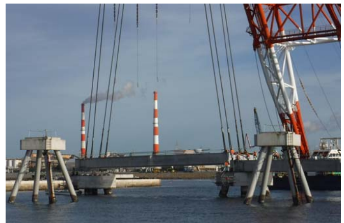
写真-18 海上通路橋の一括架設状況（左：揚炭棧橋上から移動，右：橋脚へ架設）
