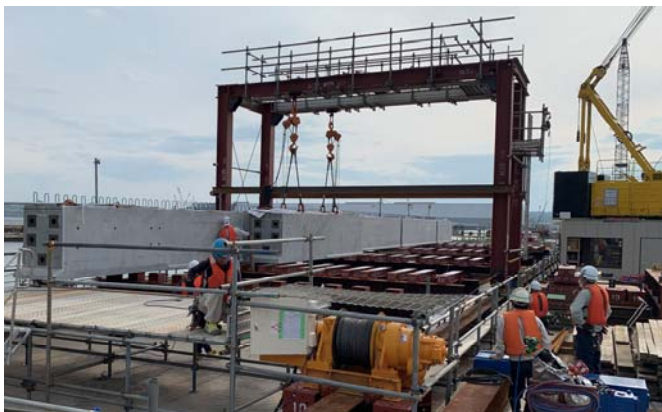
写真-13 移動式門型架構によるセグメント桁の結合状況
