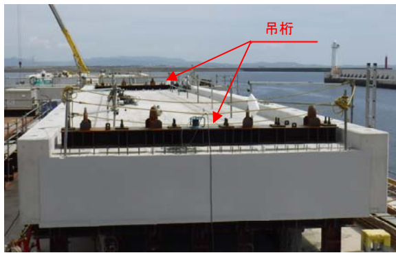
写真-15 吊桁設置完了
