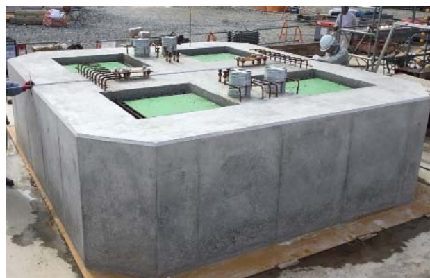
写真-8 Pca ブロック
