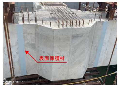
写真-6 打継部の表面保護材
