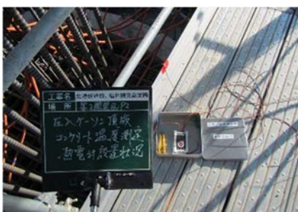
写真-3 温度計測管理
