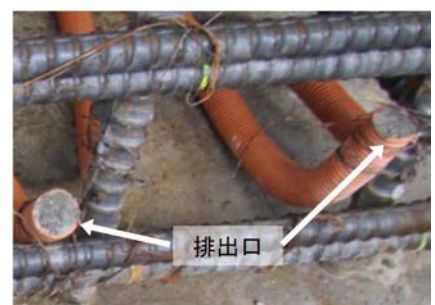
写真-5 排出口充填状況
