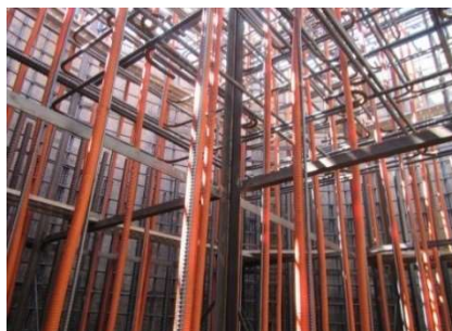
写真-4 CD 管設置状況
