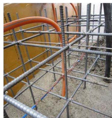
写真-2 コンクリート投入状況
