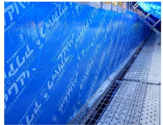
写真-5 給水型コンクリート養生シート
