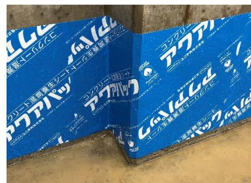
写真-3 屈曲部への貼り付け状況
