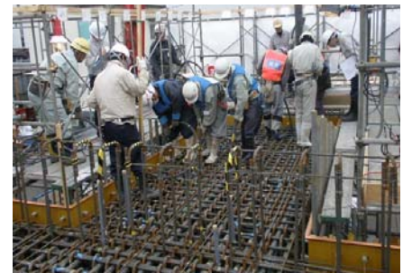
図-10 試験体の打設全景
