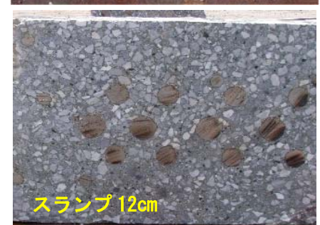
図-12 試験体の切断面の状況
