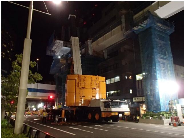
写真-3 桁吊り込み全景
