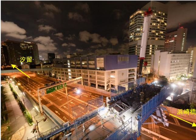
写真-5 一括架設桁吊り上げ状況
