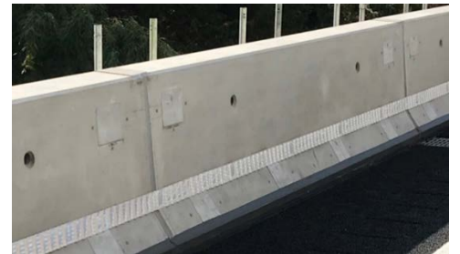
写真-1 EMC 壁高欄
