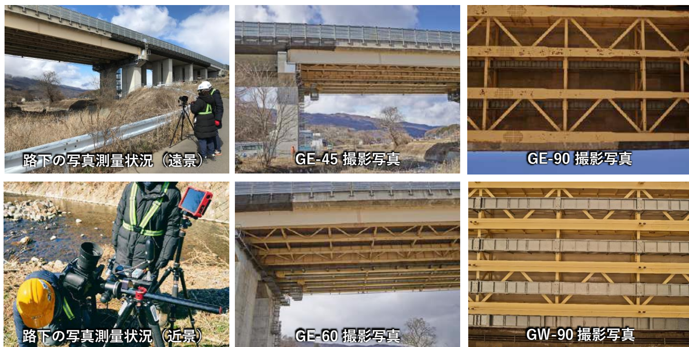
図-6 路下の写真測量状況および撮影写真の一例
