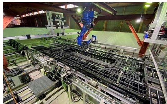
写真-1 鉄筋組立自動化システム ロボタラス
