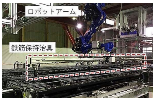
写真-3 鉄筋配置作業状況
