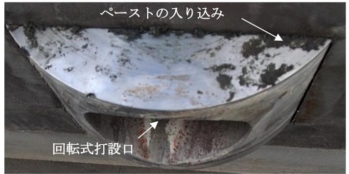
写真-7 回転式打設口の打込み後の状態
