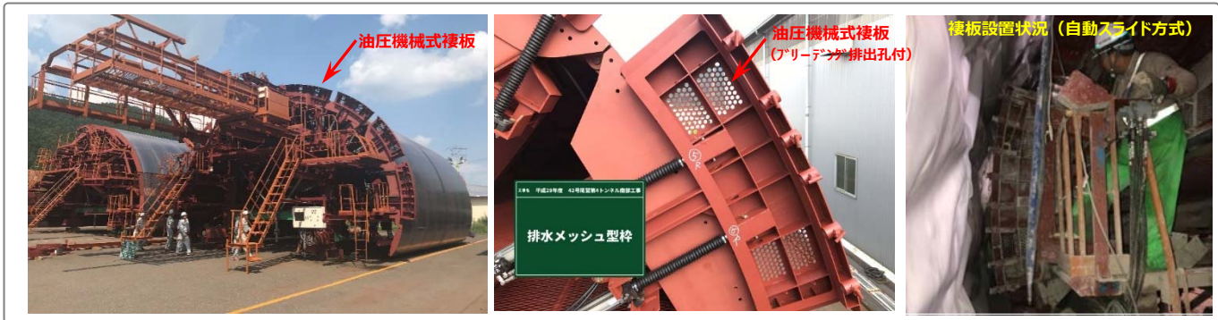
図－4 油圧機械式鋼製棲板の概要
