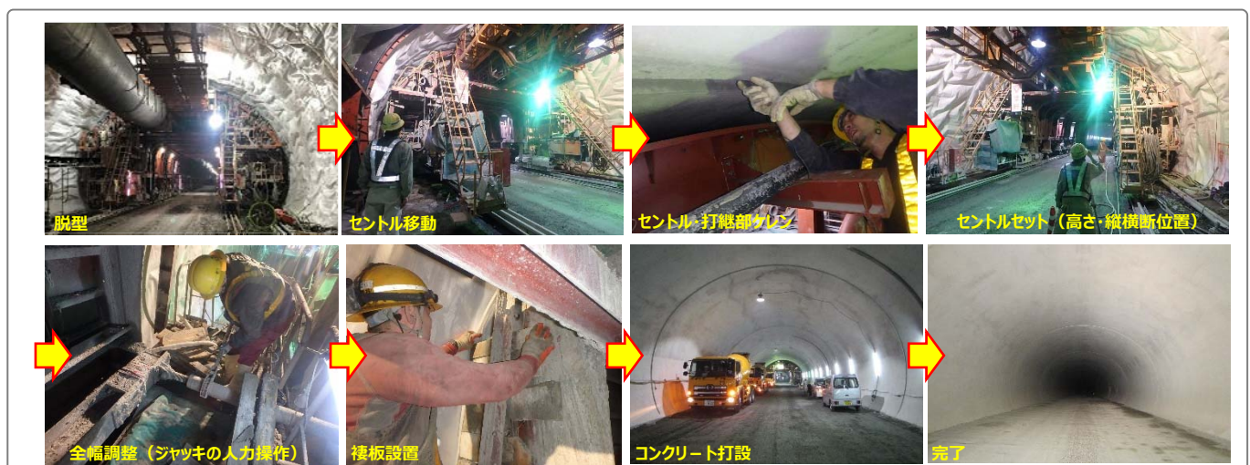
図－2 覆工一連作業の概要
