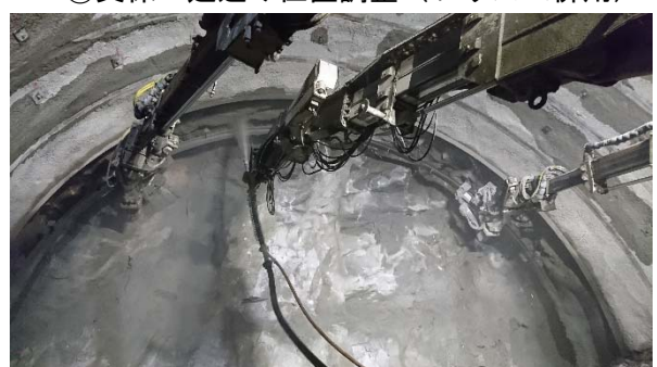
⑥支保工を把持したまま全周吹付け
