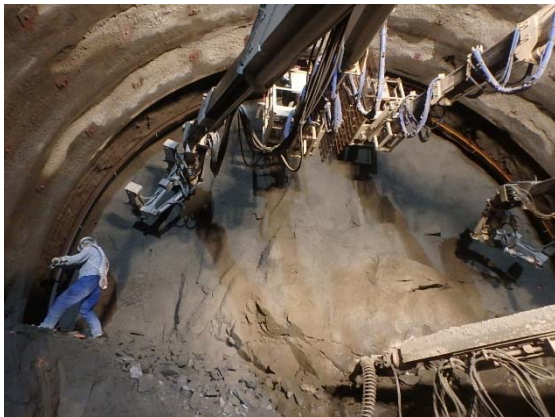
写真-1 支保工建込み状況（エレクター機能搭載一体型吹付け機採用時）
