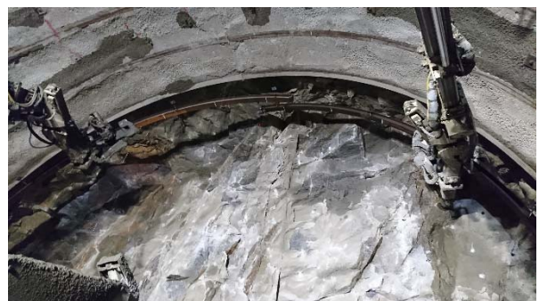
②支保工建込み（切羽側）
