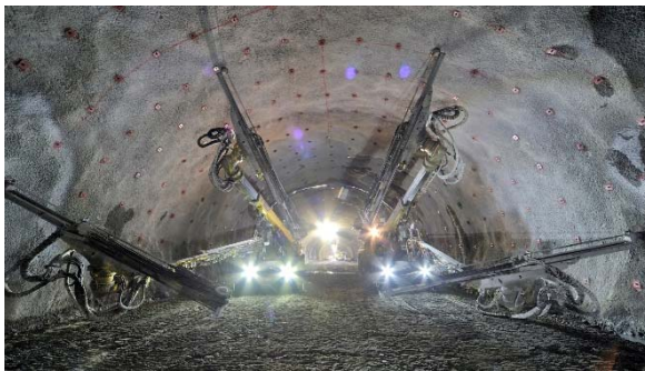
写真-6 フルオートコンピュータジャンボ（穿孔作業の無人化（既往技術））
