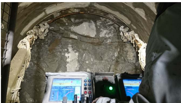
①支保工建込み（操作室）
