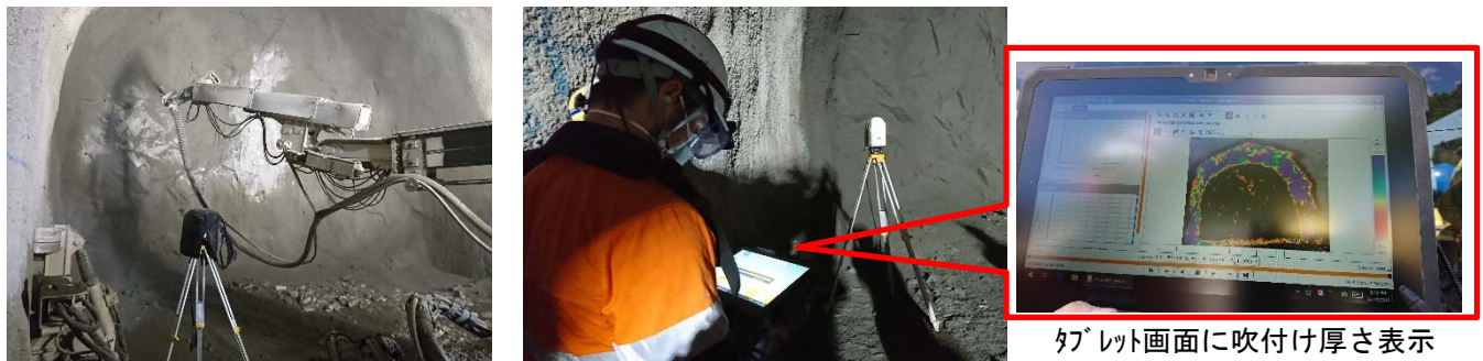
写真-5 レーザースキャナを活用した吹付け厚さ確認
