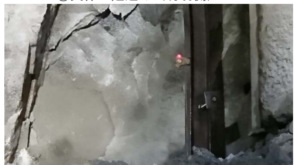
④支保工建込み位置調整（プリズム併用）
