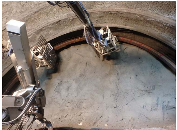
写真-1 支保工建込み状況（エレクター機能搭載一体型吹付け機採用時）
