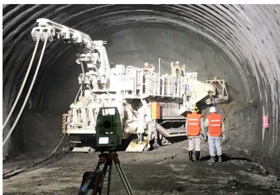
写真-9 コンピュータ制御自由断面掘進機（機械掘削作業の無人化（新技術））
