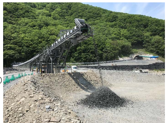
写真-8 急カーブ連続ベルコン（既往技術） （ずり出し作業の省人化）
