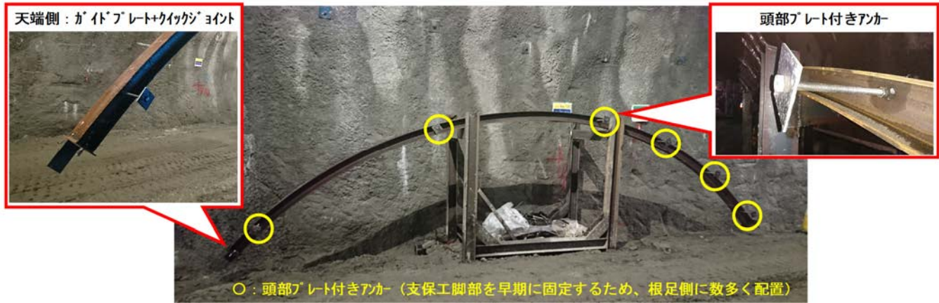
写真-3 無人化建込み用支保工（写真左は天端）
