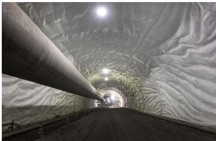
写真-11 張り付け完了全景
