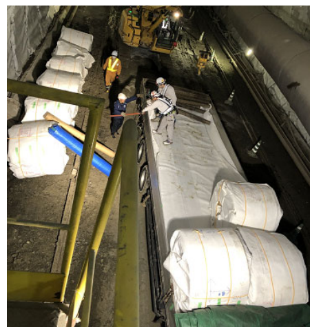
写真-7 ロール巻きシート搬入状況
