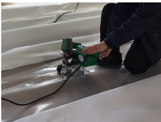
写真-3 工場溶着作業状況
