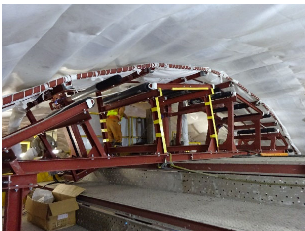
写真-6 展張装置搭載状況
