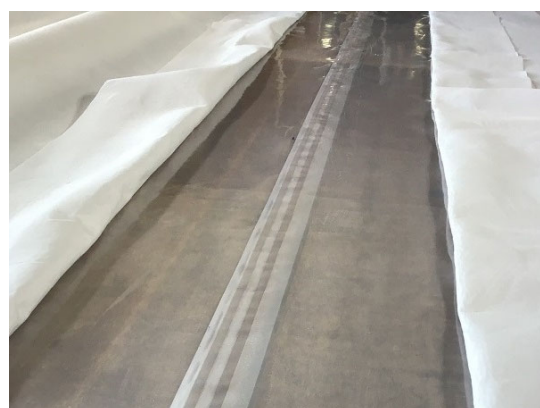
写真-4 工場溶着完了
