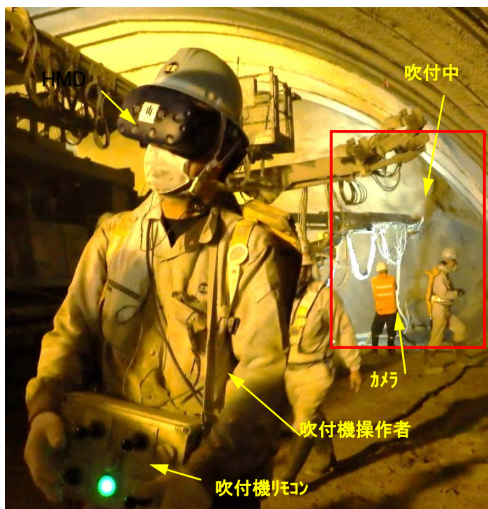
写真-4 HMD 装着下の吹付作業状況
