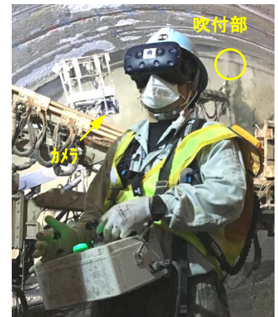
写真-9 HMD 遠隔吹付状況
