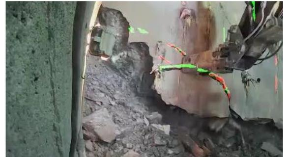
図-9 崩落発生時のクラック検知状況
