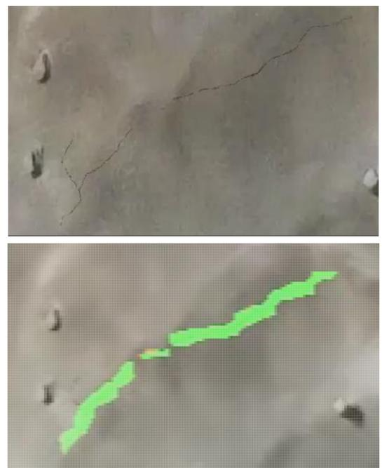
図-7 クラック検知状況の例
