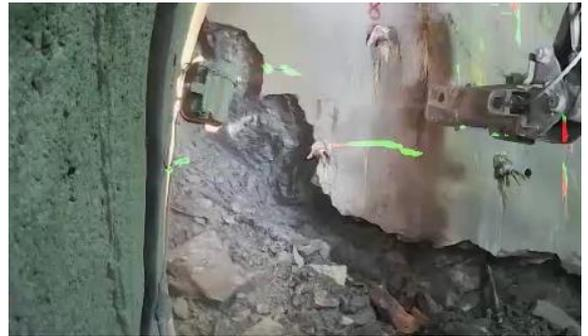
図-8 崩落発生 10 秒前のクラック検知状況
