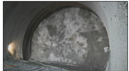
図-3 撮影した鏡吹付けコンクリート
