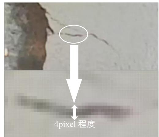
図-4 崩落前に出現したクラックの例
