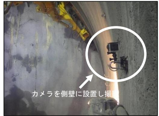
図-2 監視用カメラの設置状況
