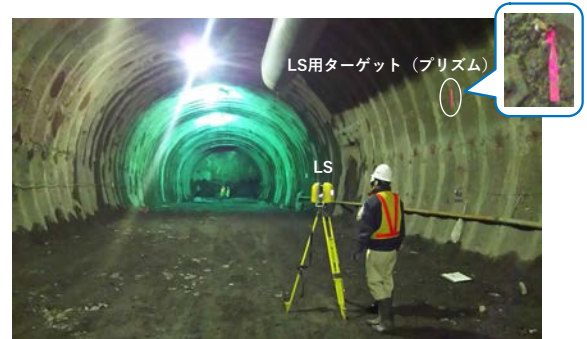
図-1 坑内の計測状況
