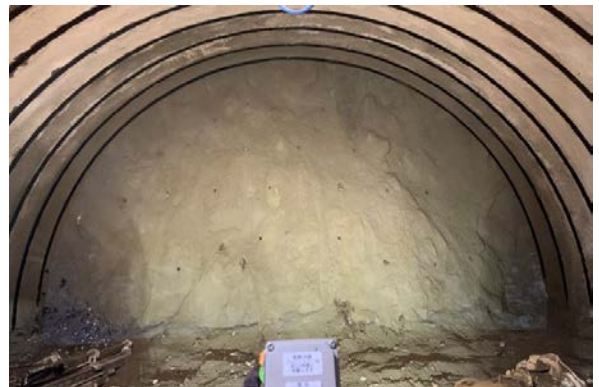
写真-1 吹付けコンクリートに覆われた切羽
