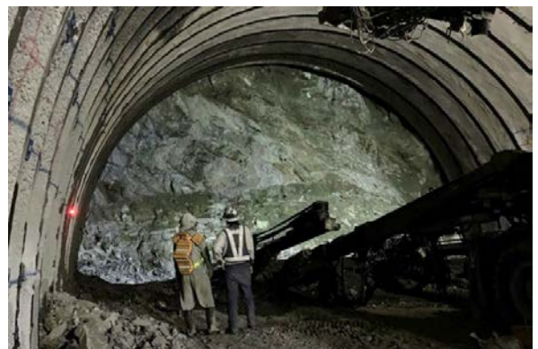
写真-2 投影された掘削面の写真
