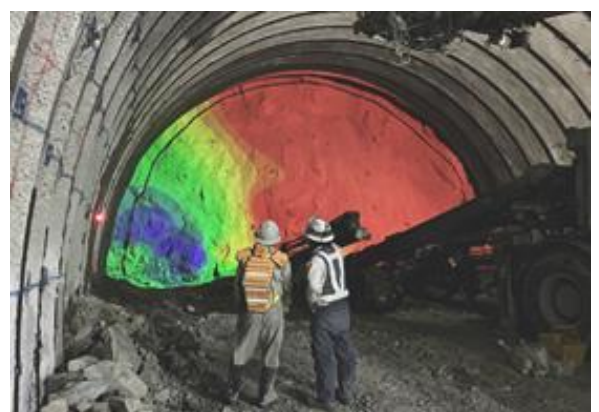
写真-3 投影された地盤の硬軟コンター図
