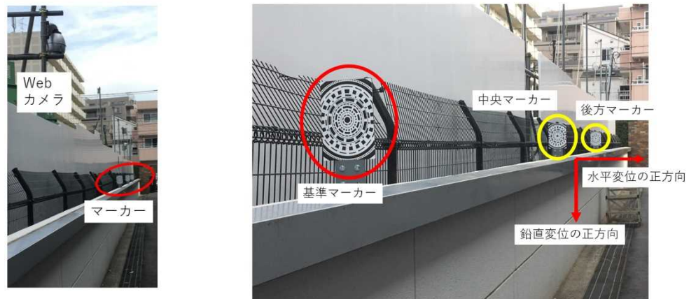
写真-2 機材設置状況
