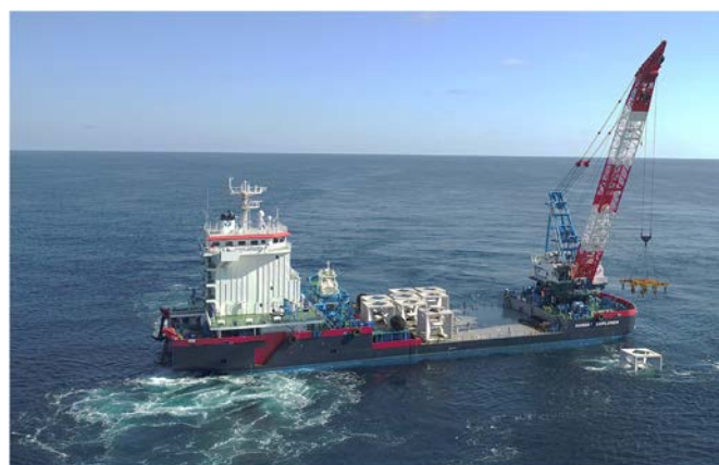
写真-1 DPS 起重機船による魚礁据付状況
