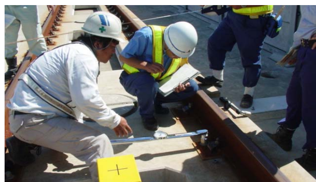
図-10 監査・検査風景
