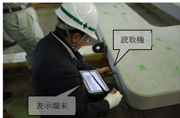
図-8 軌道スラブのRFIDタグの読取
