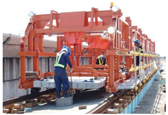
図 - 13 スラブ運搬敷設車
