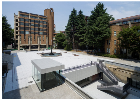
写真-1 完成した総合図書館別館
