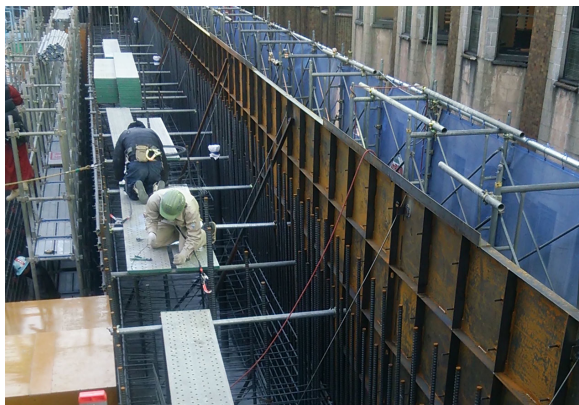
写真-3 ケーソン外周の止水鋼板
