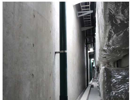
写真-5 B4F ケーソン外壁内側
