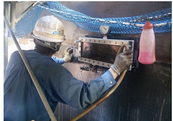
写真-4 真空箱検査(現場溶接部)
