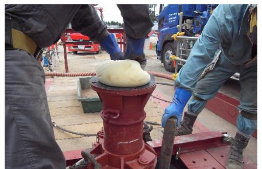
写真-9 スポンジボールの装填
