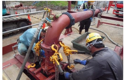
写真-8 トレミー管への圧送管の接続
