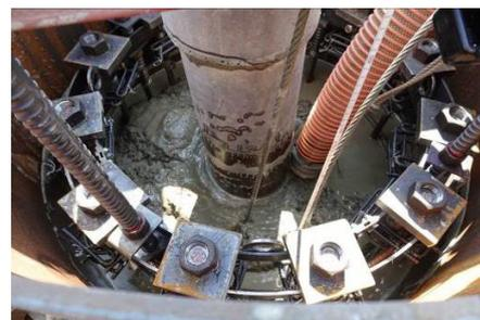
写真-5 打込み状況(バキューム処理)
