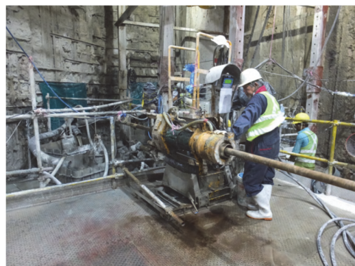
(b) 作業構台上での状況
