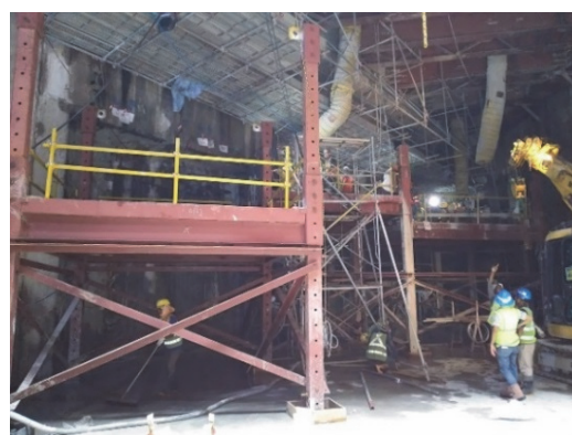
(a) 作業構台の全景
