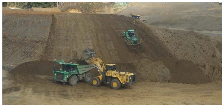
写真-1 スtockパイル切崩し・積み込み状況
