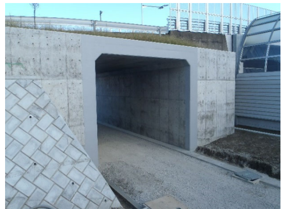
写真-3 完成全景（発進側）
