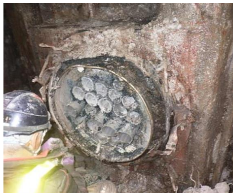
図15 既設管の充填状況
