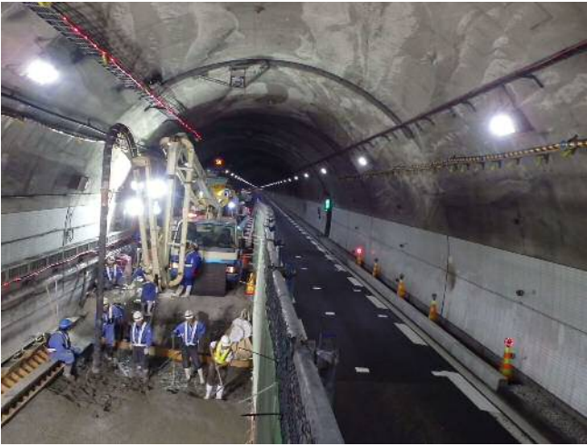
写真-3 コンクリート打設状況
