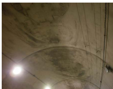
写真-2 標準的な工法の覆工
