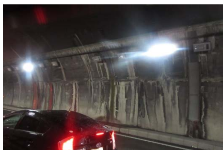
写真-1 在来工法の覆工
