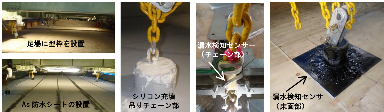
写真-3 防水防音型吊り足場構造
