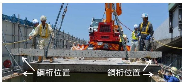
写真-8 鋼桁位置を越えた床版の一括撤去状況
