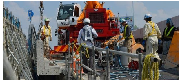
写真-5 高欄の先行撤去
