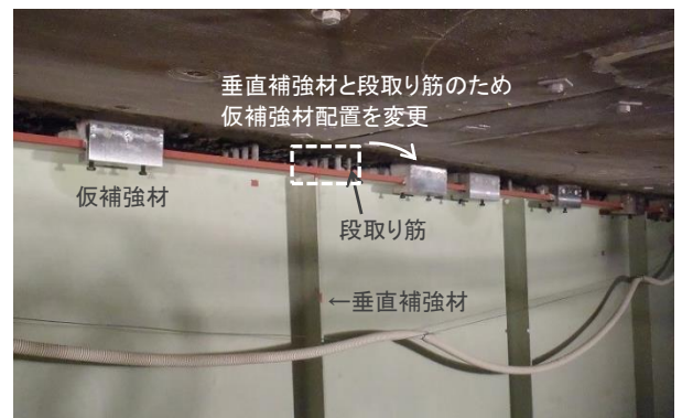
写真-4 仮補強材設置状況
