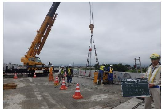
図-6 壁高欄撤去状況（70tRC）
