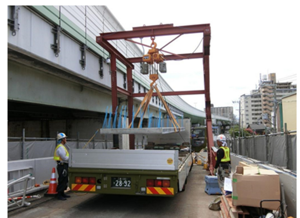
写真-8 荷降し設備での UFC 床版吊上げ
