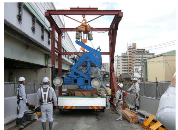
写真-7 専用架設機の搬入
