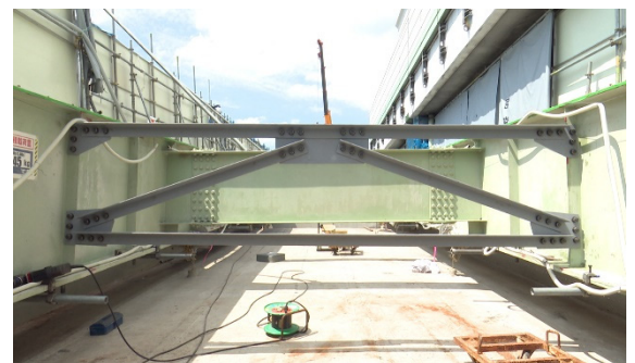
写真-6 専用架設機使用時の鋼桁補強
