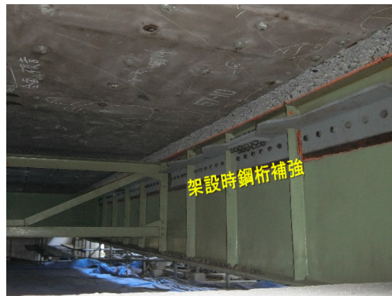
写真-5 クレーン架設時の鋼桁補強例
