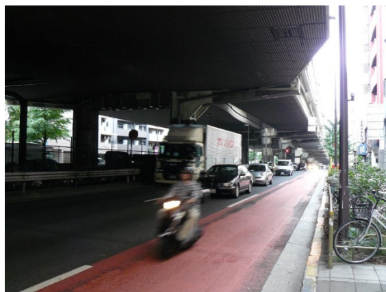
写真-2 側道に挟まれた都市高速道路
