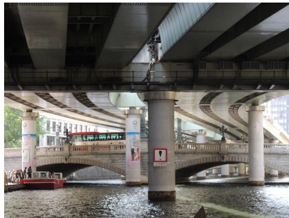
写真-3 水路上を通る都市高速道路
