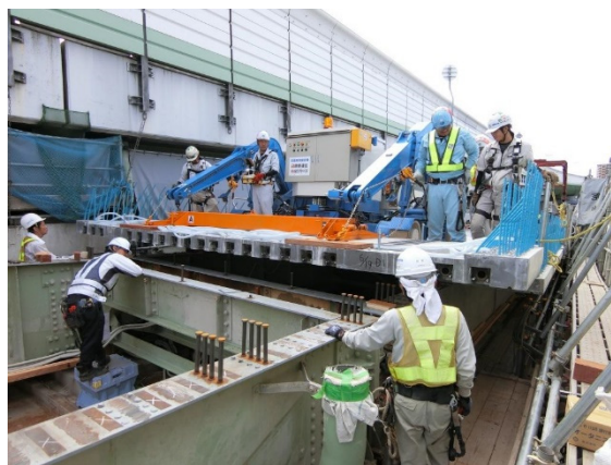
写真-10 平板型 UFC 床版の設置
