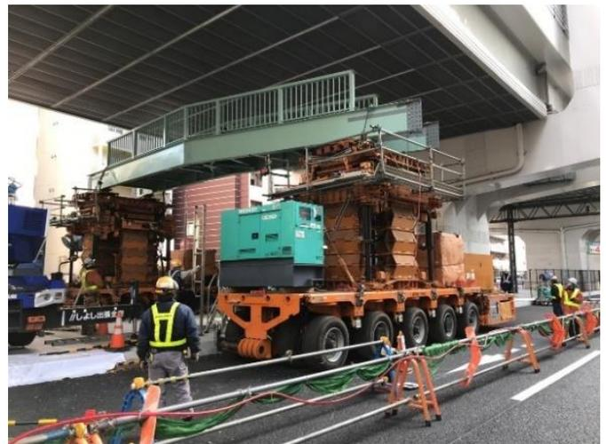
写真-1 ドーリーによる桁の架設状況
