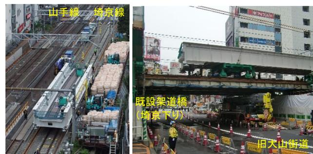
写真-5 新設桁縦取り移動状況
