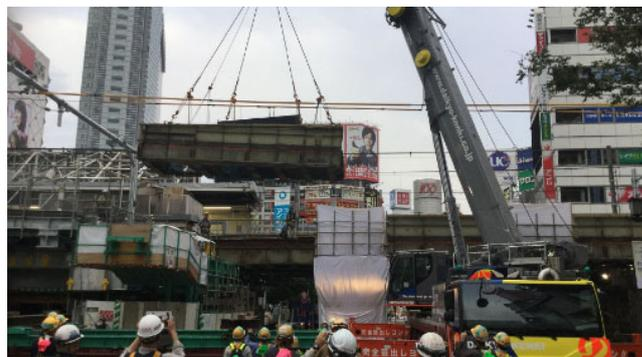
写真-3 既設桁撤去状況
