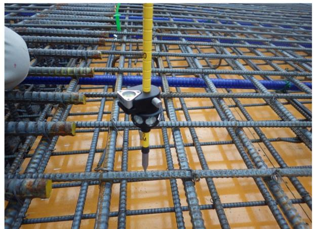
写真-5 鉄筋の上かぶり管理
