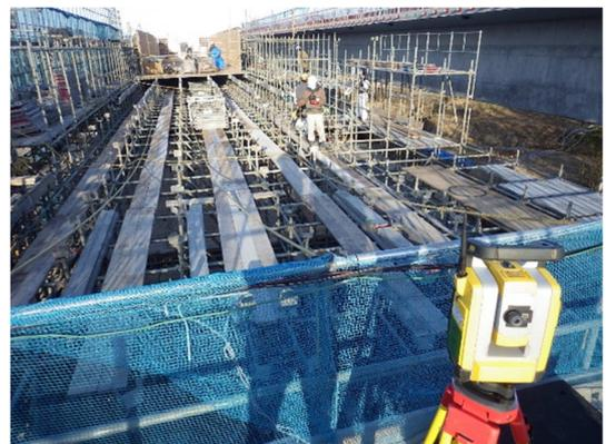
写真-6 支保工ジャッキセット状況
