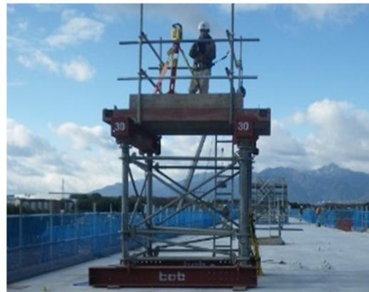
写真-1 測量用架台
