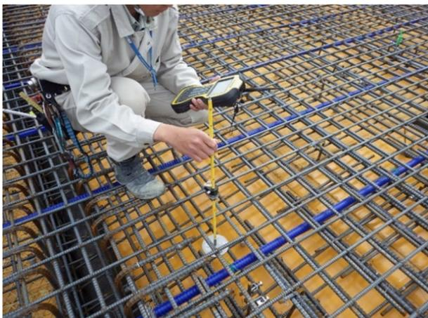
写真-4 PCケーブルの設置管理
