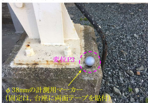
写真-2 基礎に貼り付けたマーカ
