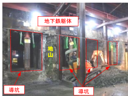
写真-1 導坑間の掘削前状況
