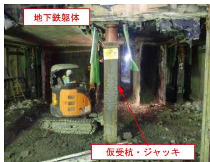
写真-2 導坑間の掘削状況
