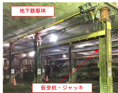
写真-3 導坑間の掘削後の状況
