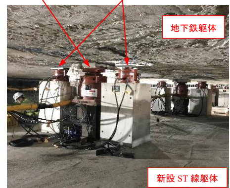
写真-4 仮受けジャッキ（中央）と、本受けジャッキ（両脇）配置状況
