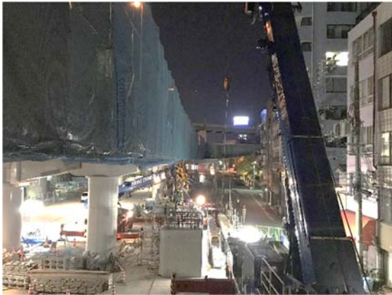
写真-2 施工場所付近
