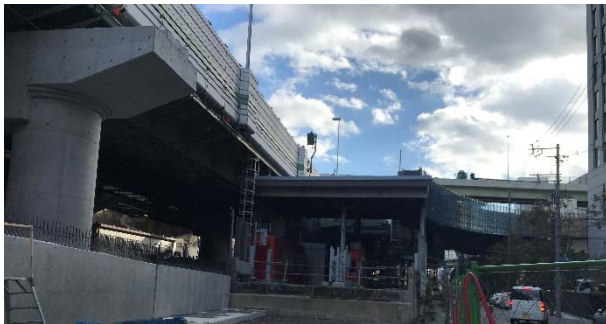
写真－1 施工場所付近
