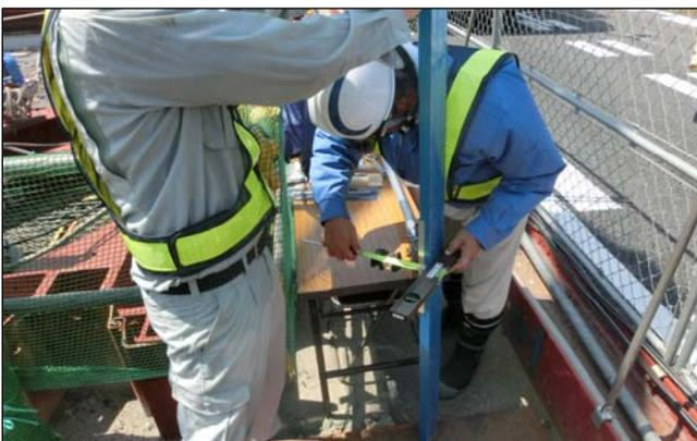
写真-3 トンボのオフセット高さ計測状況
