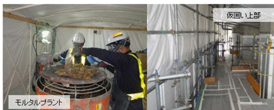
写真-4 飛散養生状況
