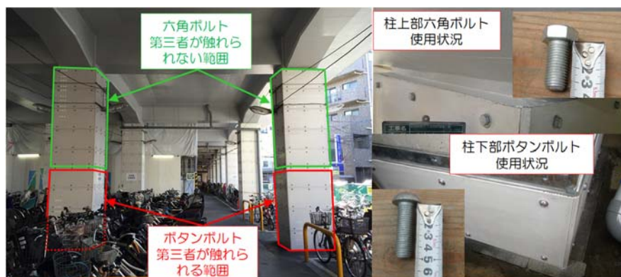
写真-5 ボタンボルトの採用
