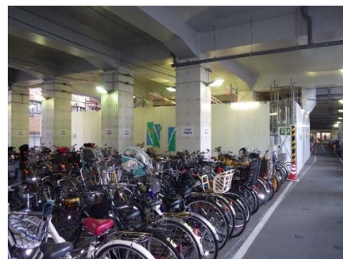
a) 高架橋下
