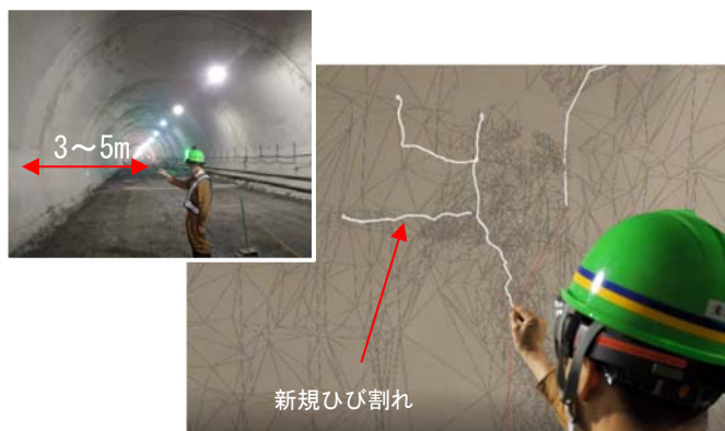
図-15 ひび割れ作図状況（トンネル側壁部）
