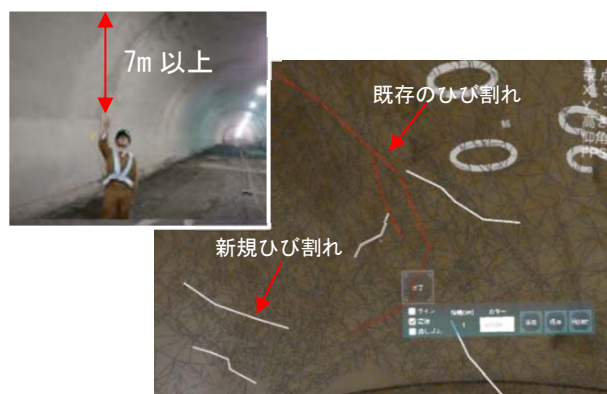
図-16 ひび割れ作図状況（トンネル天端）
