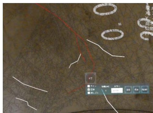
図-9 ひび割れ朱書き表示例
