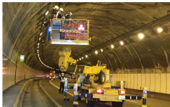
図-1 トンネル点検状況
