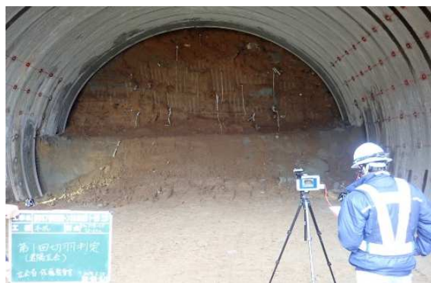
図-7 遠隔立会システムによる切羽判定状況
