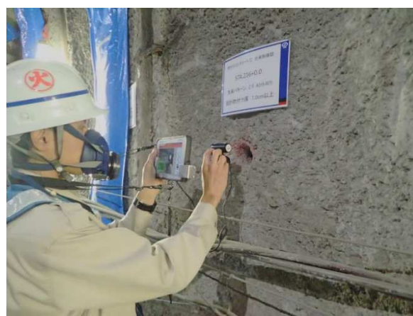
遠隔立会システムを利用した検査状況
