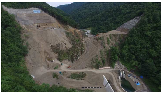
図-1 ダム建設現場 (岐阜県 内ヶ谷ダム)
