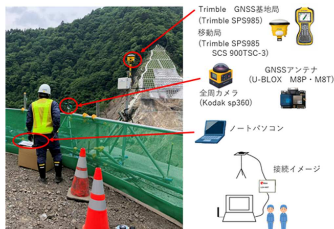
図-3 調査状況および使用機器
