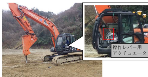
図 - 6 MG 検証に利用したバックホウ (ブレーカー使用時)
