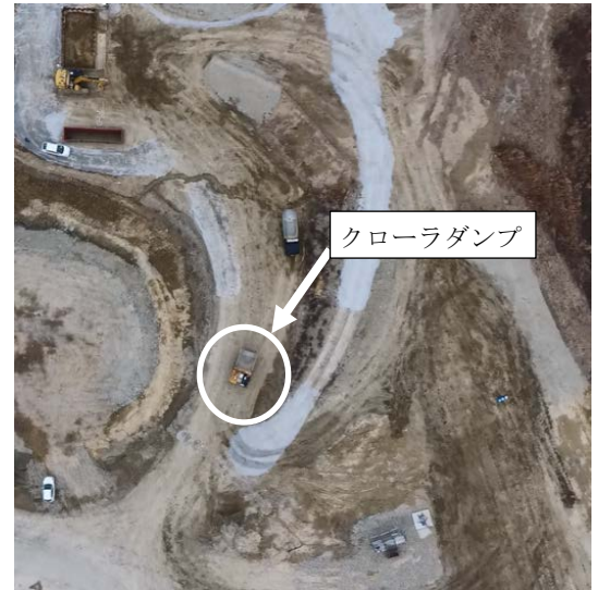
図-10 実験ヤードを走行するクローラダンプ （航空映像写真）
