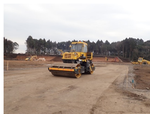
写真-4 自動運転による施工状況
