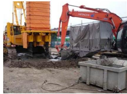
図-6 ベッセルへの排土投入状況
