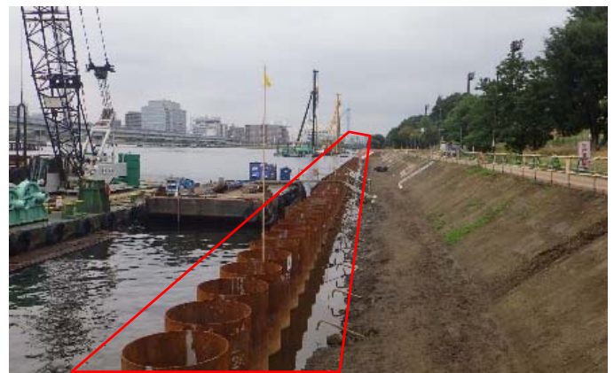
(b) 鋼管矢板設置後
