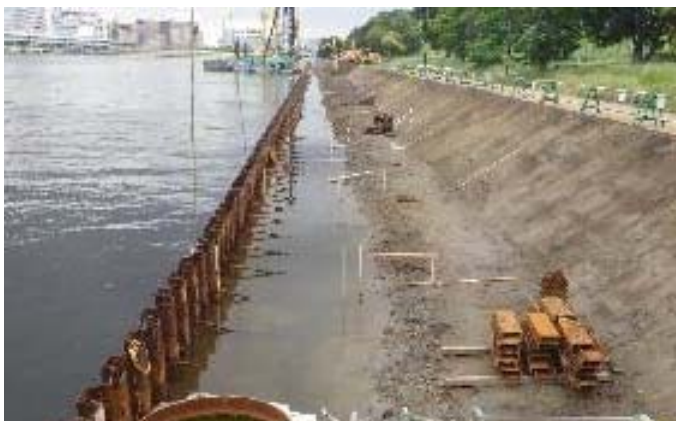
(a) 鋼管矢板設置前
