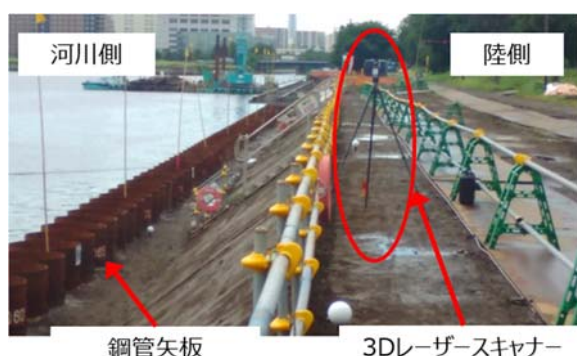
写真-2 3次元レーザースキャナー計測状況
