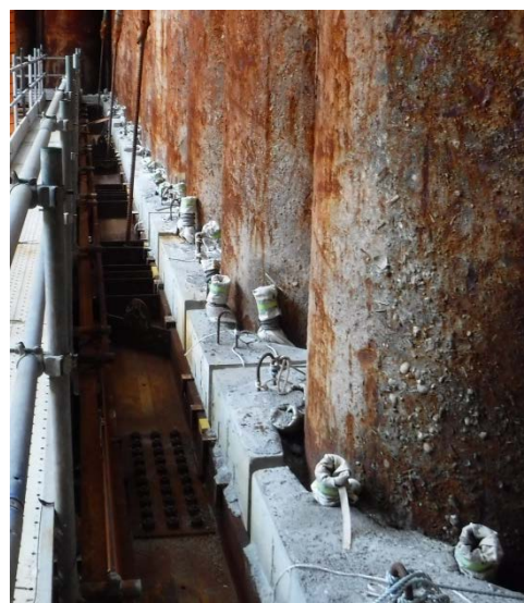
写真-2 水中間詰めコンの設置
