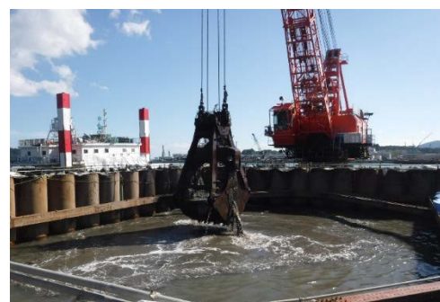
写真-3 井筒内掘削状況
