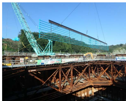
写真-6 鉄筋のブロック施工
