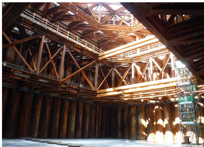
写真-5 井筒内ドライアップ完了
