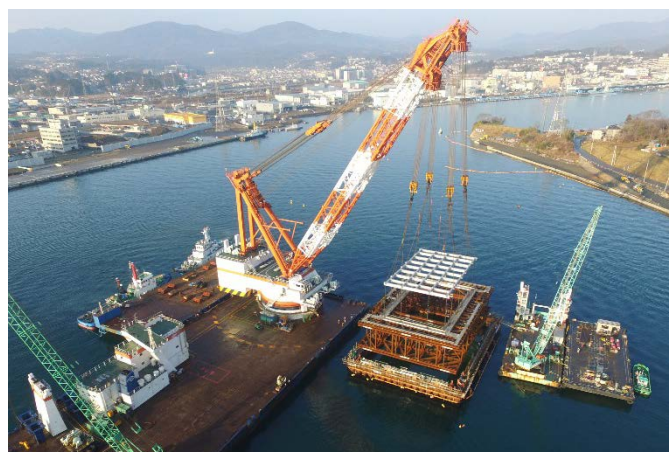
写真-4 トラス型支保工の一括架設
