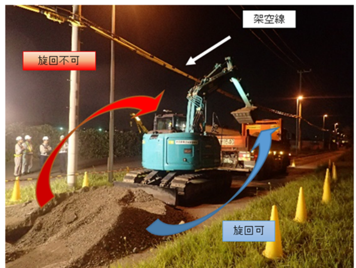
写真-8 高圧線近接作業での運用
